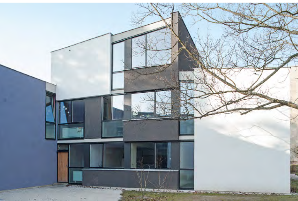
Haus 18 nach der Sanierung © Brenne Architekten
