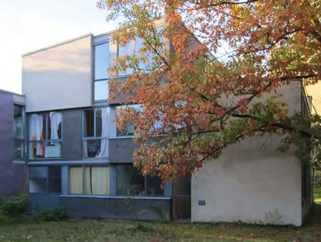
Haus 18 vor der Sanierung © Brenne Architekten
