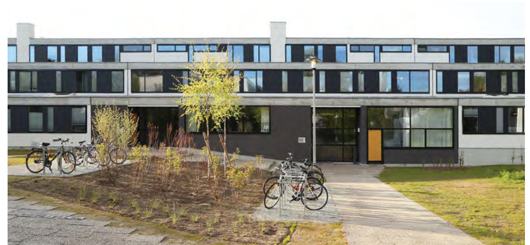
Ansicht Eingangsbereiche Häuser 9–10 © Mila Hacke
