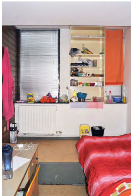
Haus 22–23, Studentenbude vor der Sanierung © Brenne Architekten
